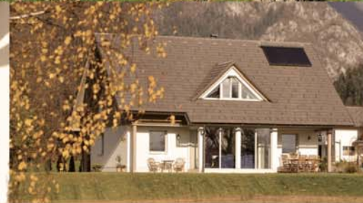
PASIVNA HIŠA PETEK - IZGRADNJA EKO PRODUKT D.O.O.
